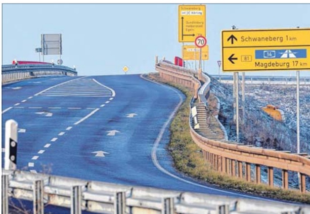
Der gesamte Brückenbereich der K 1263 ist so solide mit Leitplanken versehen, dass Fußgängern das Verlassen des Straßenbereiches praktisch unmöglich gemacht wird.
